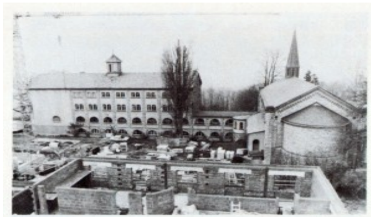
Rohbau des neuen Klosters, im Hintergrund das alte Klostergebäude
